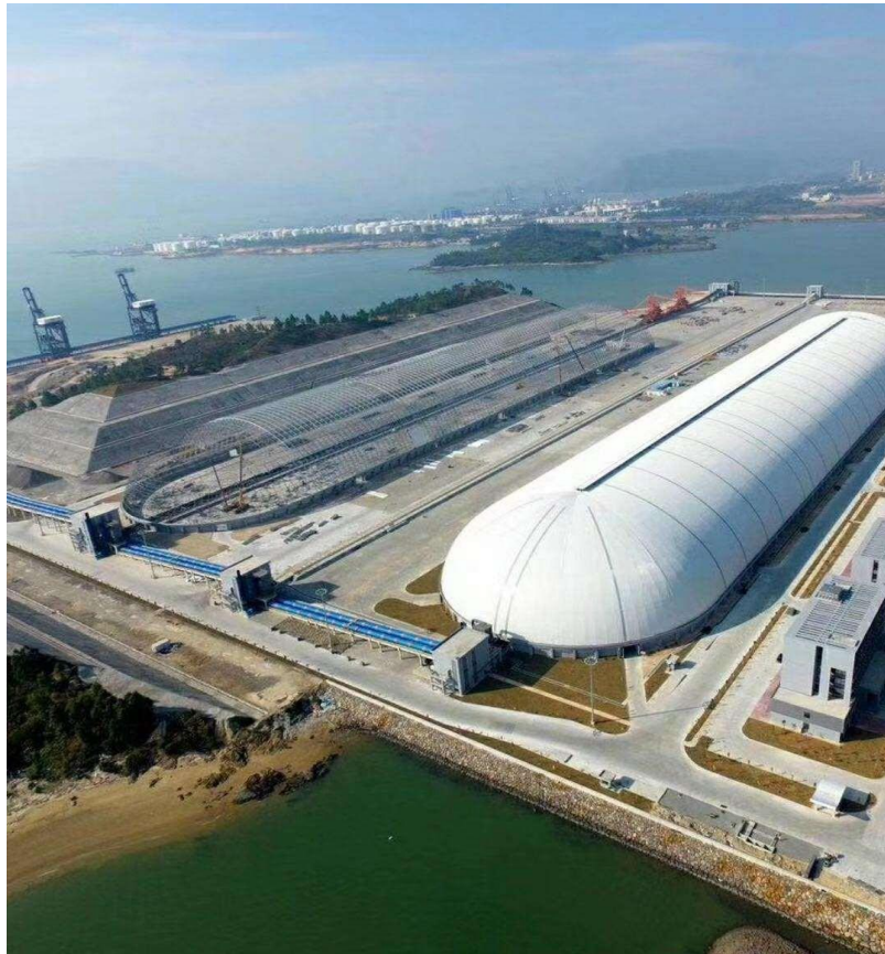
Galpão de carvão com vão de 145 m
