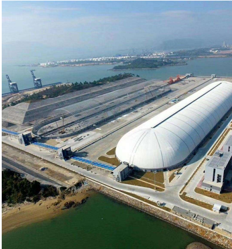
Galpão de carvão com vão de 145 m
